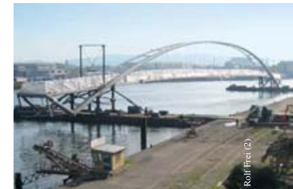
Mit Spezialschiffen wird die Brücke in die richtige Position geschoben.
