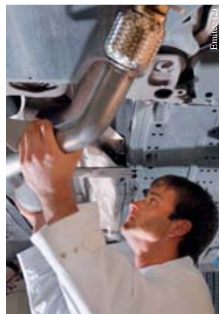
Montage eines Partikelfilters
